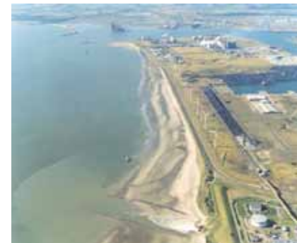
Luchtfoto / Aerial photo: De Kaloot, 2003 Foto / Photo: F.A.D. van Nieulande
